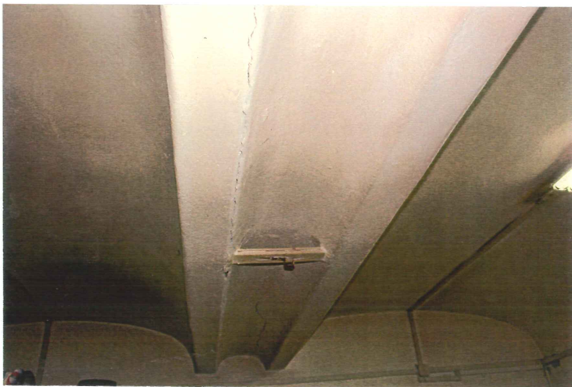
Fot.36 i 37. Zarysowanie na wyszpałdowaniu belki głównej w piwnicach budynku frontowego od strony ulicy Starzyńskiego
