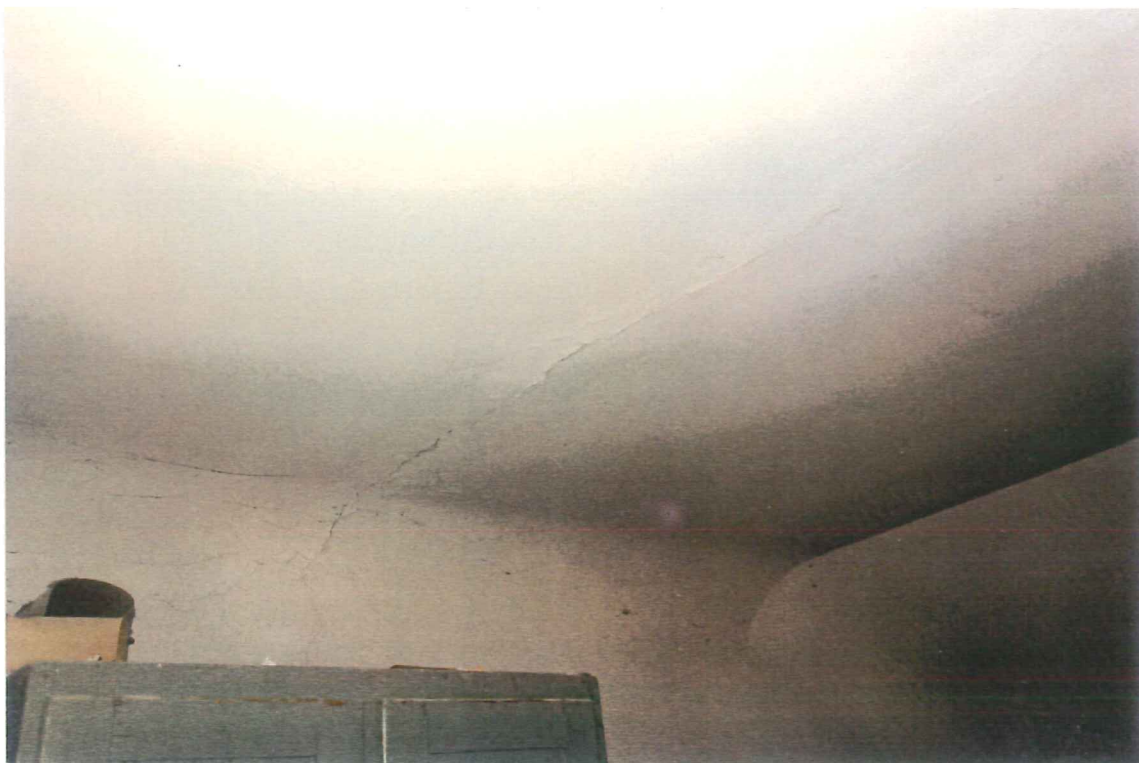
Fot.20. Sporadyczne zarysowanie stropu w następstwie klawiszowania belek
