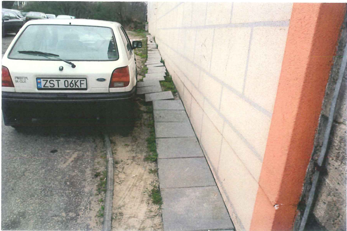
Fot. 5. Bezpośredni styk nawierzchni parkingu z budynkiem Wojewódzkiej Komendy Policji
