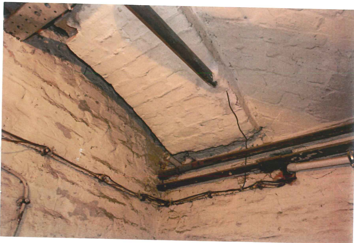
Fot. 33. Uszkodzony podciąg łukowy w kluczu i w wezłowieu czasie prowadzenia robót instalacyjnych
