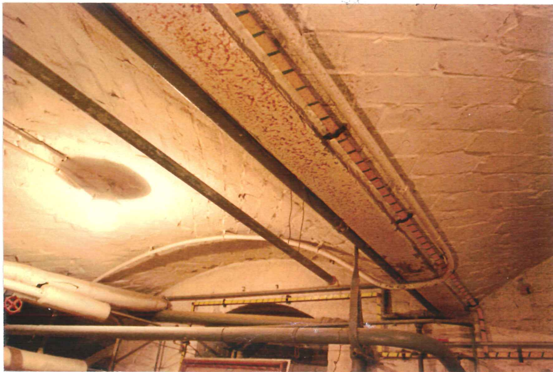
Fot.34. Sklepienie łukowe w piwnicach budynku frontowego oparte na dźwigarze stalowym
