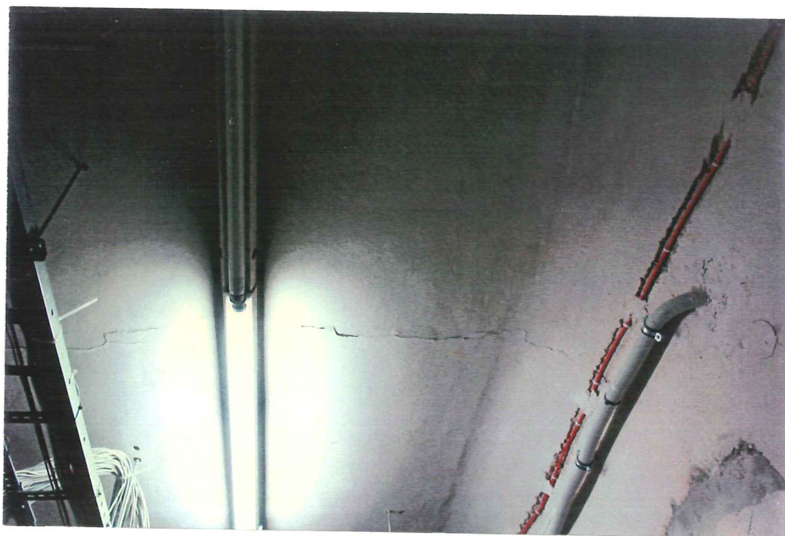
Fot.38 i 39. Przykłady zarysowań na sufitach piwnicznych
